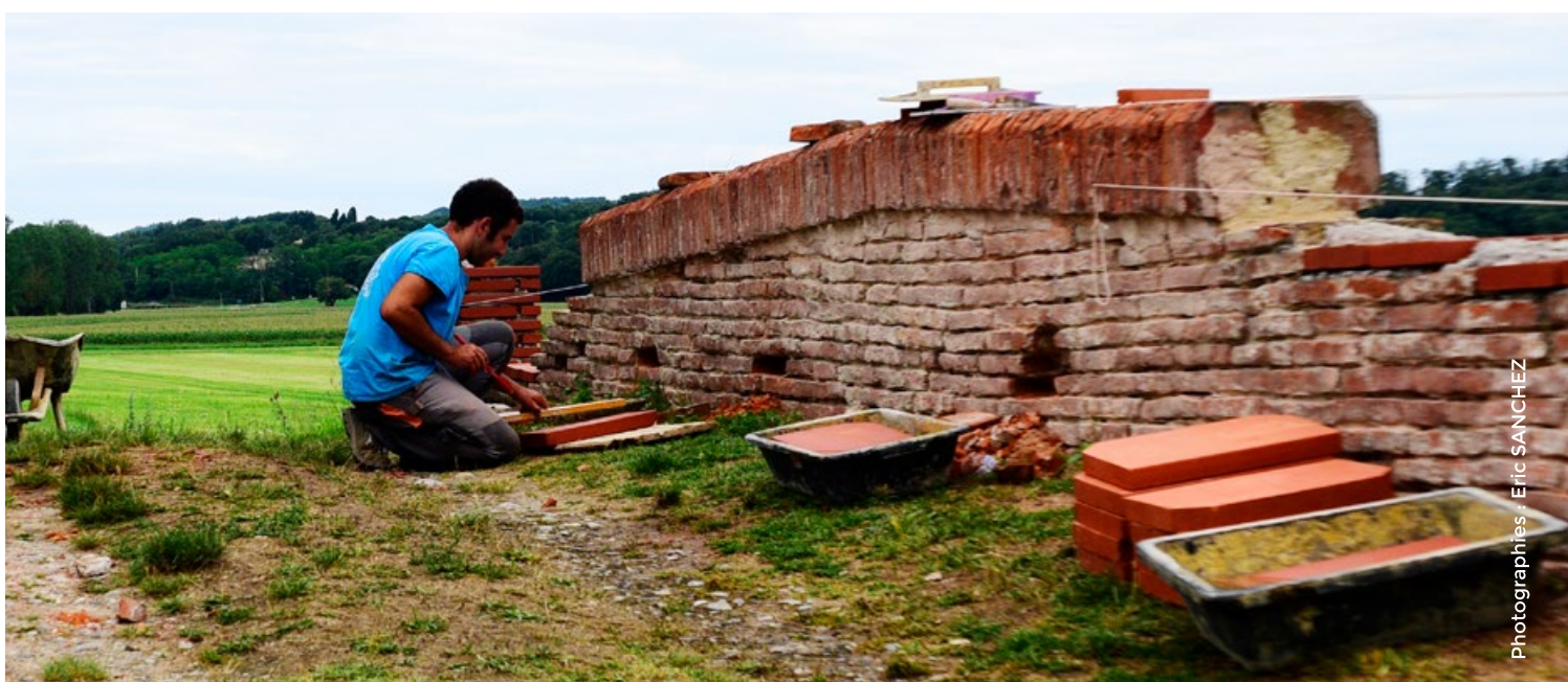
Rénovation du pont de Bourse localisée sur le ruisseau de la Mouillonne
